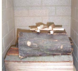
Befüllen Sie den Feuerraum mit der Längsseite der Holz-scheite nach vorne.
